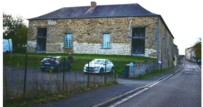
Vue du grenier à sel-prison © BE-AUA
