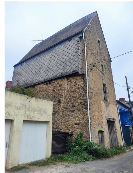
Vues du grenier à sel © BE-AUA
