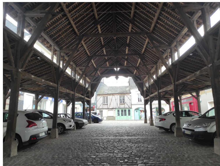
Vues des halles © BE-AUA
